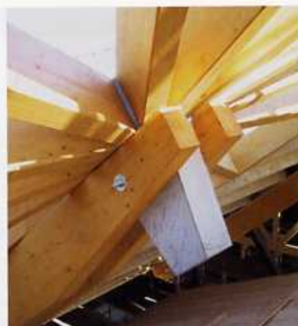
Innenseite des Konstruktionsknotens
