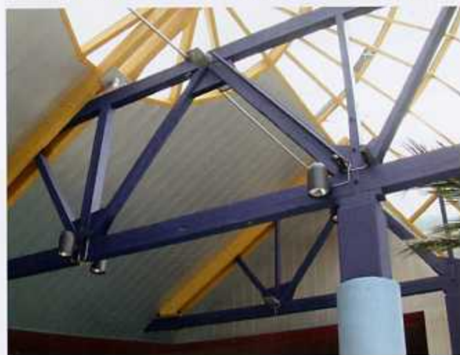
Holzkonstruktion der Hallenbinder; Foto: Inco Ingenieurbüro, Aachen
