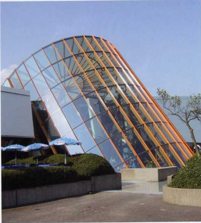
Der Anbau; Foto: Heuer • Faust Architekten, Aachen
