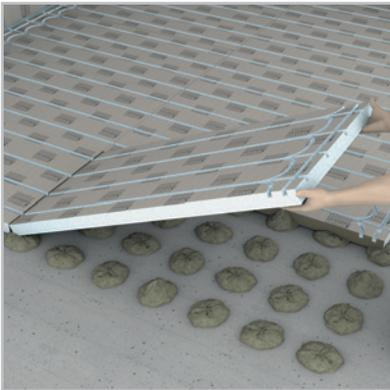
FLOOR-WH F ... ist sowohl für den Einsatz auf Holzböden als auch auf mineralischen Untergründen wie z.B. Beton oder Estrich geeignet. FLOOR-WH F 30 muss dabei immer vollflächig verklebt, FLOOR-WH F 50 kann auch auf Batzen gesetzt werden (Batzenabstand  $\leq$  200 mm). Bei Holzböden ist immer eine vollflächige Verklebung erforderlich!
