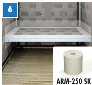
Armer tous les raccords, supérieurs et inférieurs, avec la bande d'armature en fibre de verre ARM-250 SK ...
