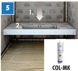
Coller l'élément d'assise sur les supports et les murs avec COL-MK (**alternative :** COL-AK). Vérifier l'horizontalité du siège !
