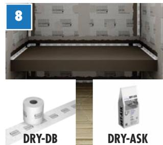
En zone humide, étanchéifier en plus avec les composants de bande d'étanchéité DRY-DB... avec de l'enduit d'étanchéité DRY-ASK.
